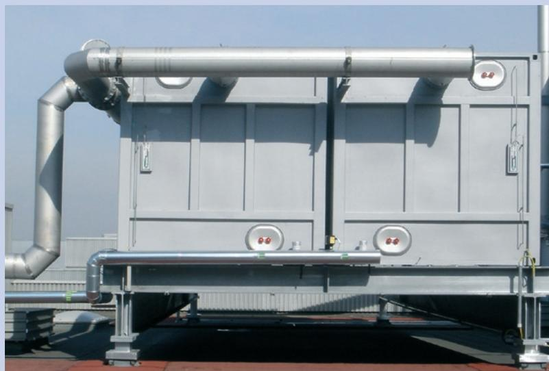
**Bild 3:** Frontansicht des Biofilters der BMW AG, Standort Regensburg, Abluftvolumen 10 000 m<sup>3</sup>/h
