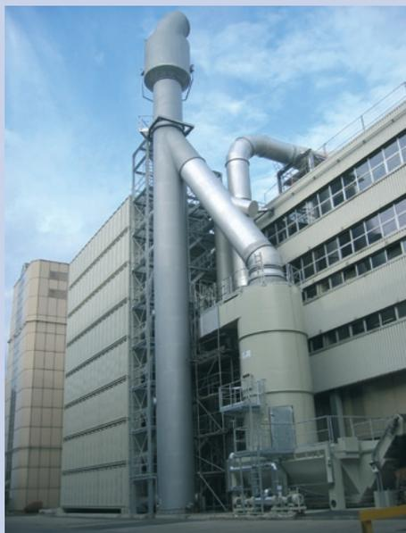
**Bild 2:** Zweistufige Biofilteranlage, DaimlerChrysler AG, Abluftvolumen 120 000 m<sup>3</sup>/h ▶
