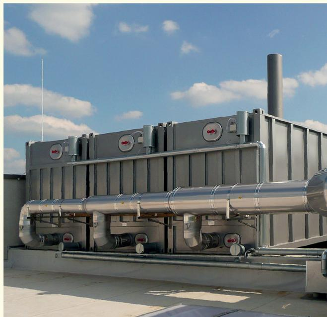
Bild 1. Beispiel einer der dachaufgestellten Anlage zur Reinigung von Abluft aus mehreren Spritzständen und Trocknern. Rohgaskonzentration: ca. 600 mg/m<sup>3</sup>, Volumenstrom: ca. 10 000 m<sup>3</sup>/h.
