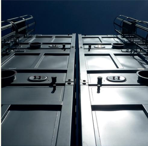
**Bild 3.** Jeweils zwei der sechs Biofilter dieser Anlage eines Schraubenbeschichters werden zur Erreichung einer verbesserten Durchströmung hintereinander durchströmt. Rohgaskonzentration: ca. 1 000 mg/m<sup>3</sup>, Volumenstrom: ca. 12 000 m<sup>3</sup>/h.
