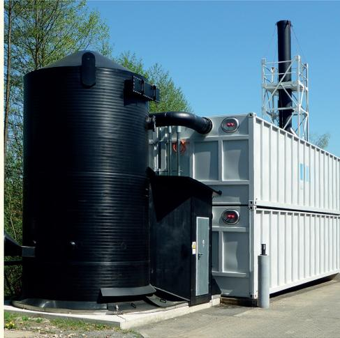
**Bild 4.** Biofilter mit vorgeschaltetem Biowäscher zur Abluftbehandlung eines Metallbeschichters. Rohgaskonzentration: ca. 800 mg/m<sup>3</sup>, Volumenstrom: ca. 14 000 m<sup>3</sup>/h.
